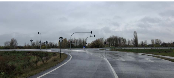
Abb. 19 Knotenpunktausbau L 178, 17.11.2022 © ICL
