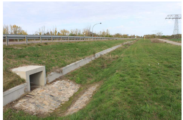
Abb. 18 Amphibiendurchlass L 178, 28.10.2022 © ICL (Eigene Aufnahme)
